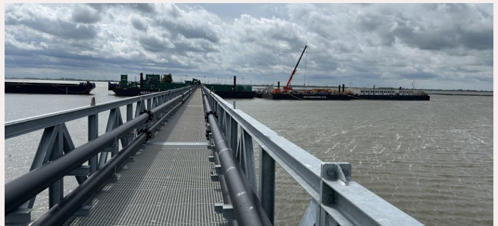
Der Verbindungssteg zwischen den Pontons wird wieder aufgebaut. / Quelle: TenneT
