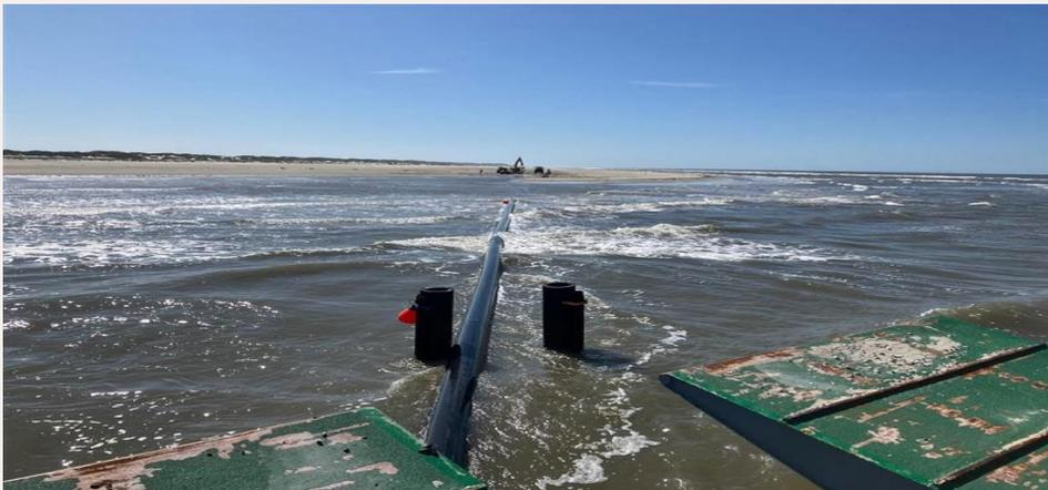
Einschwimmen der Kabelschutzrohre / Quelle: TenneT
