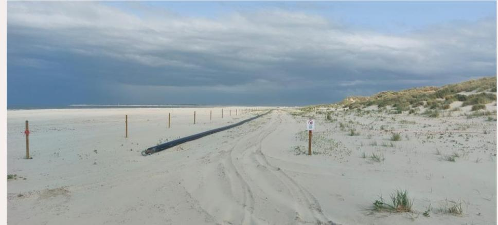
Kabelschutzrohrablage am Nordstrand im umzäunten Gebiet / Quelle: TenneT
