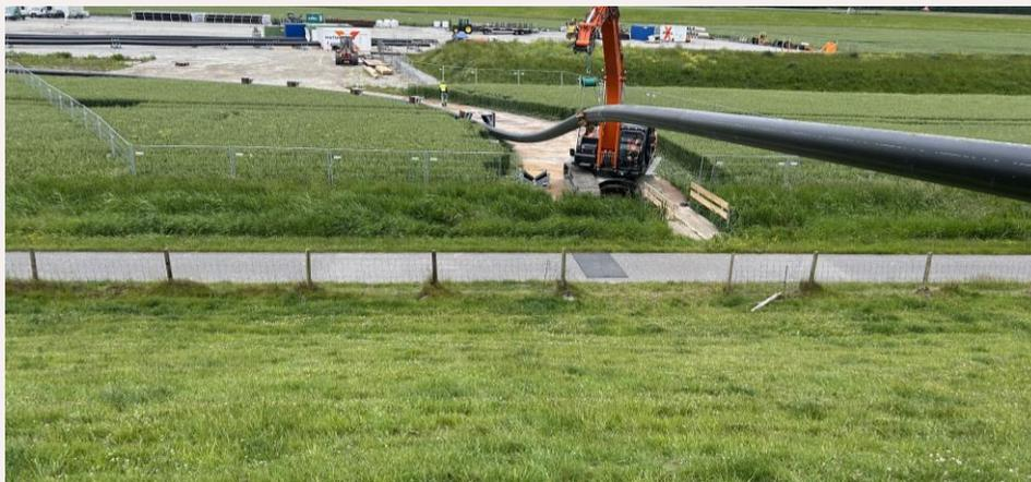
Kabelschutzrohrtransport über den Deich in Dornumergrode / Quelle: TenneT
