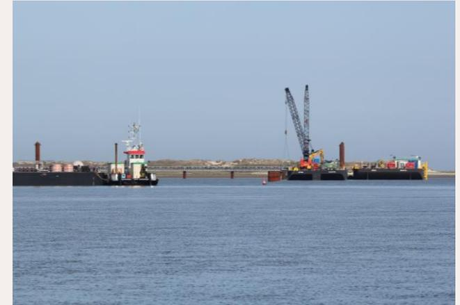
Errichtung des Wattstegs von Arbeitspontons aus / Quelle: TenneT
