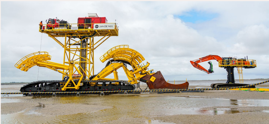
Der Sunfish als Verlegegerät mit Vibrationsschwert im Einsatz. / Quelle: TenneT
