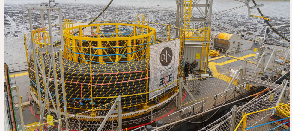
Auf dem sogenannten Turntable des Verlegepontons ist das Stromkabel aufgerollt. / Quelle: TenneT
