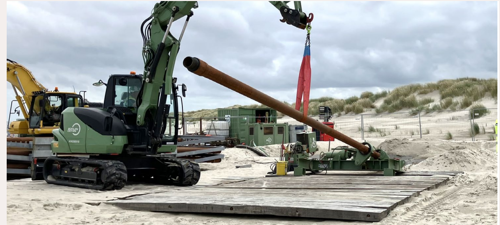
Arbeiten am Nordstrand / Quelle: TenneT
