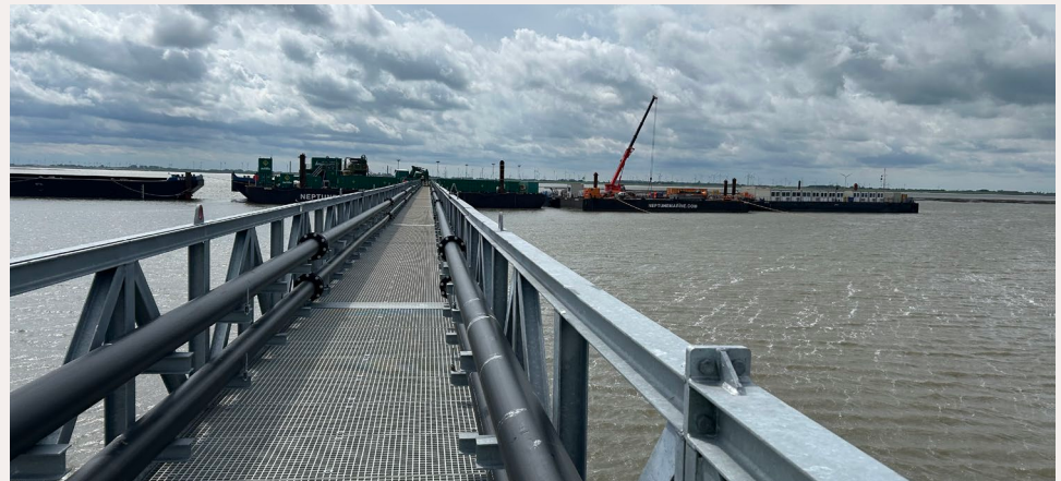
Verbindungssteg zwischen den Pontons / Quelle: TenneT
