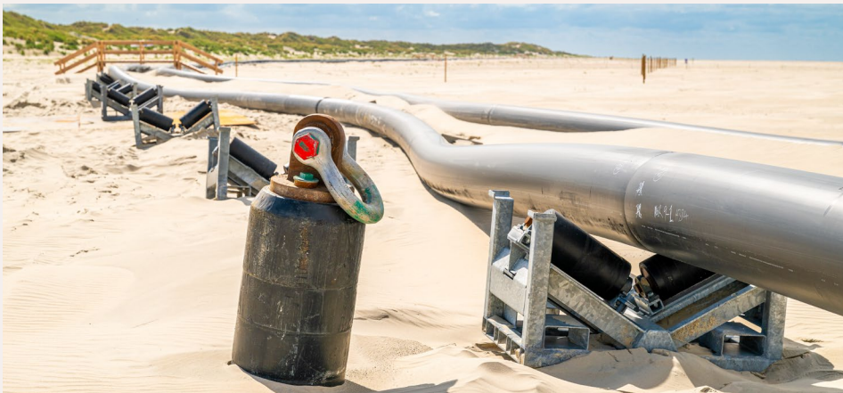
Kabelschutzrohrablage am Nordstrand / Quelle: TenneT
